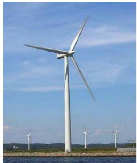
Figure (II-3) : Eolienne à axe horizontal
