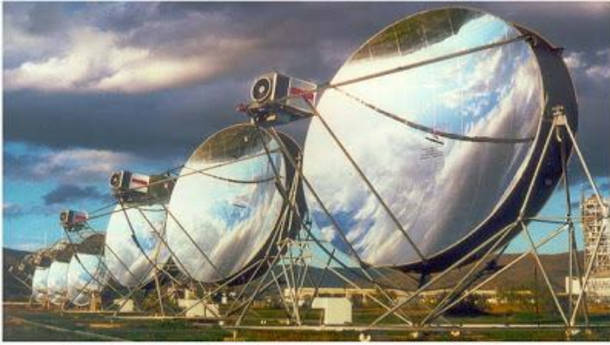
الصورة 8: مرآة مقعرة قطرها سبعة أمتار ونصف مع محرك ستروكلج بقوة 9 كيلواتة بحرك الأبحاث بالعميريا بإسبانيا
