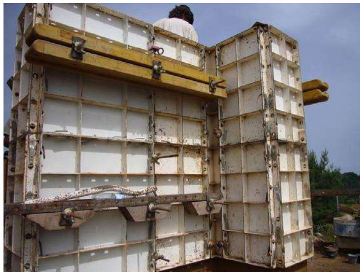
Figure I.17 Coffrage métallique du pisé moderne.
