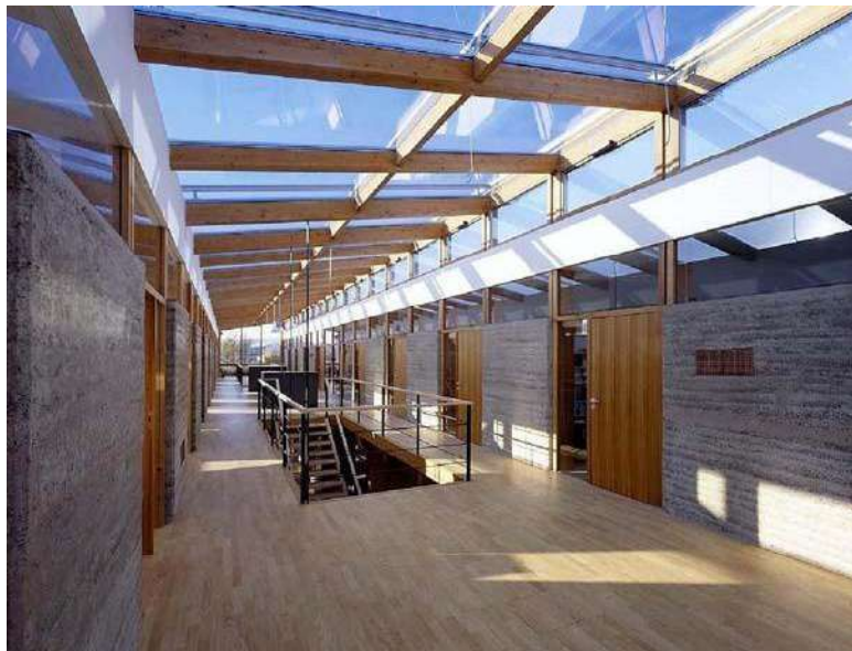
Figure I.20 Un bâtiment construit par 160 éléments préfabriqués.
