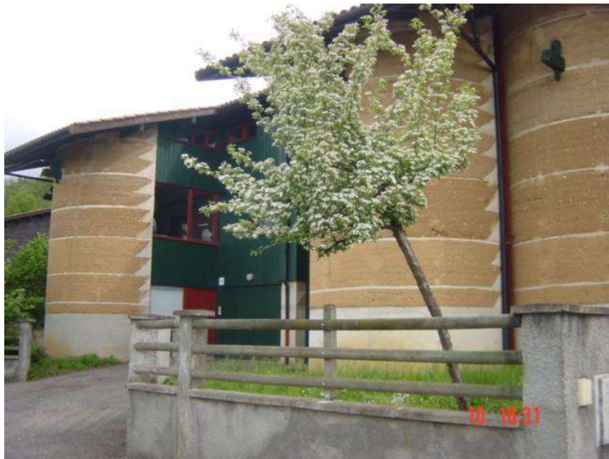
Figure I.15 Maison en pisé moderne construite au cours des années 1980.
