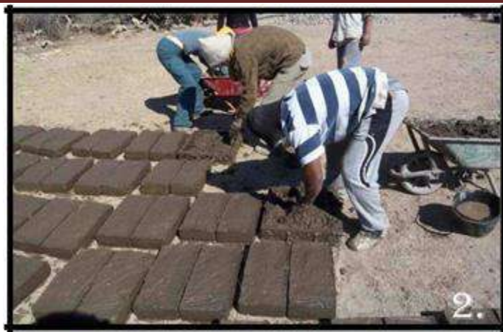
Figure I.5 : Moulage et séchage des blocs adobes.
