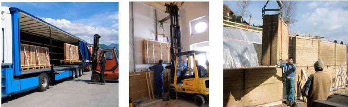
Figure I.19 Transport et mise en œuvre des éléments préfabriqués.
