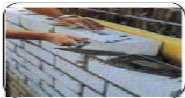
Figure I.4 Mur en brique silico-calcaire.
