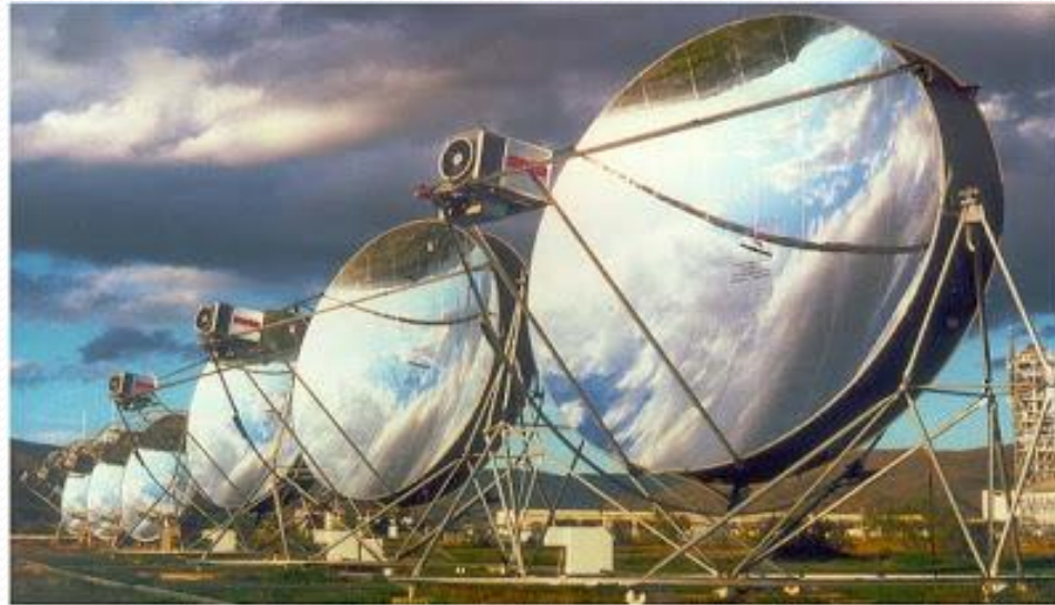
الصورة 8: مرآة مقعرة قطرها سبعة أمتار ونصف مع محرك ستيرلنج بقدرة 9 كيلوات يتركز الأبحاث بالعميريا بإسبانيا
