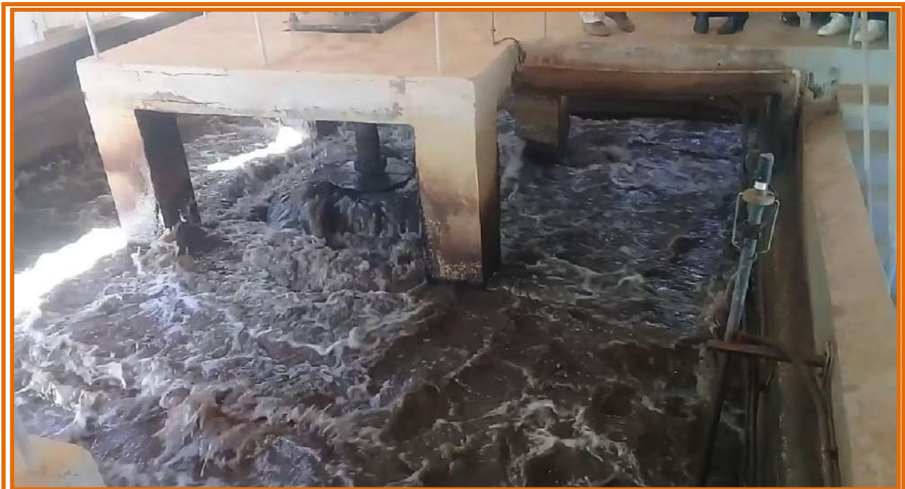
Figure 8 : Bassin d'aération
