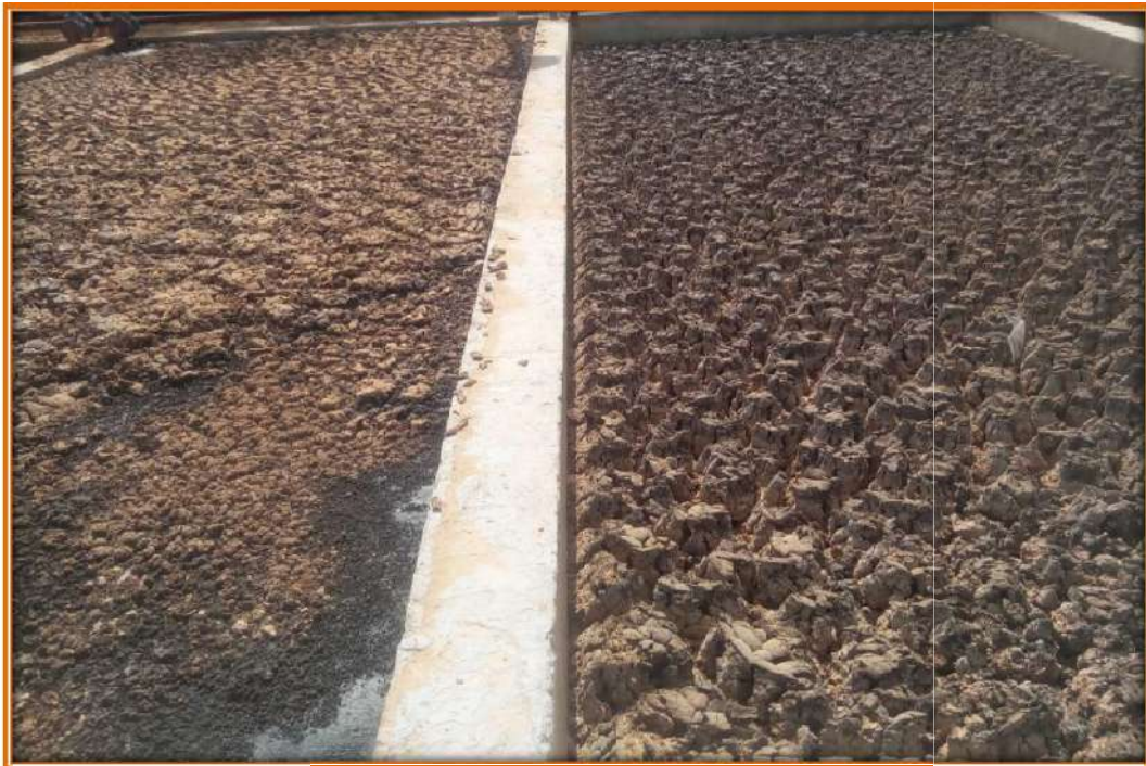
Figure 12 : lits de séchage
