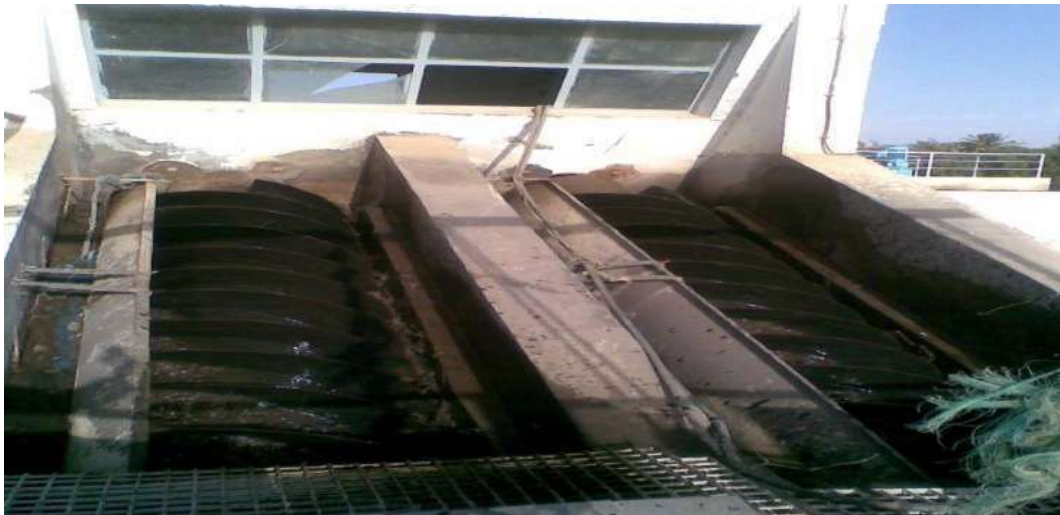
Photo 9 : Schéma du vis d'Archimède STEP Touggourt
