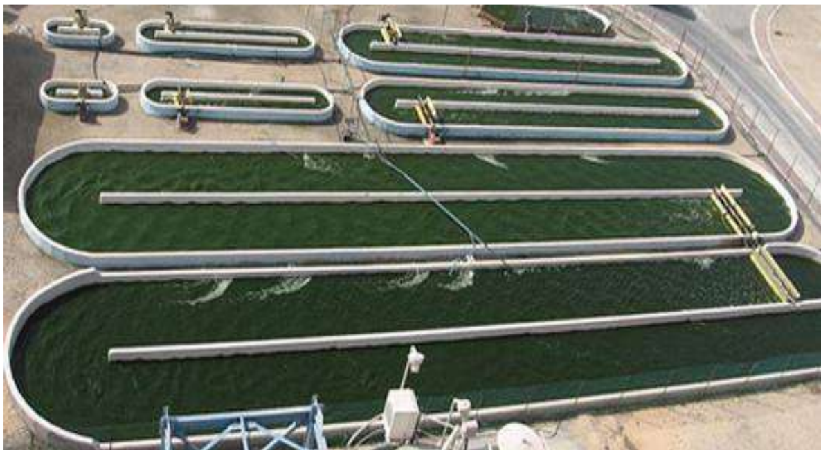
Figure I.1: Système ouvert de type "raceway" utilisés pour la culture d'algues [13].
