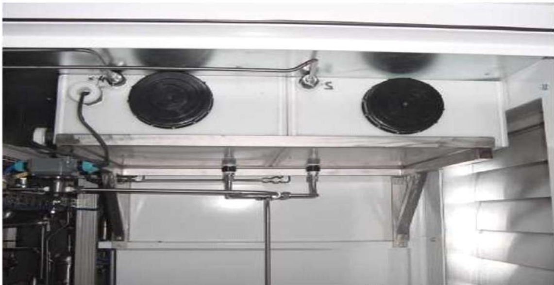
Figure II-11 : réservoir de coupure.
