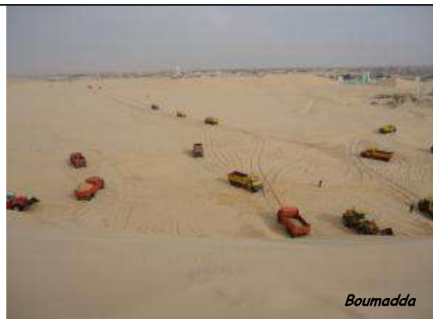
Photo 35 : Opération de remblayage des Ghouts.
