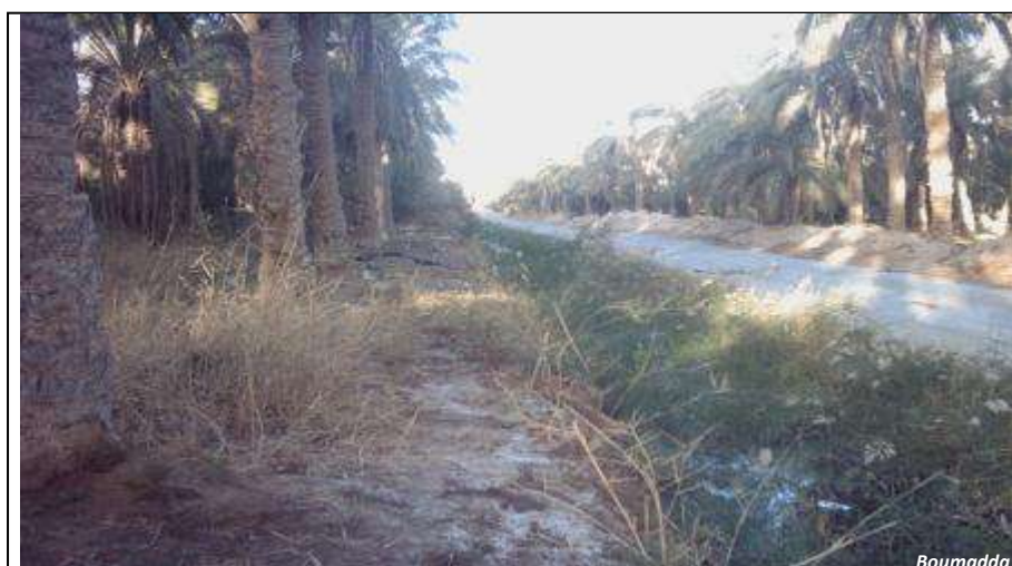
Photo 45 : Drain envahi par les mauvaises herbes dans la palmeraie de N'goussa.
