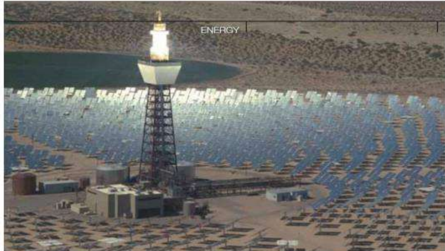
Figure I.13 : Centrale solaire à tour dans Californie.
