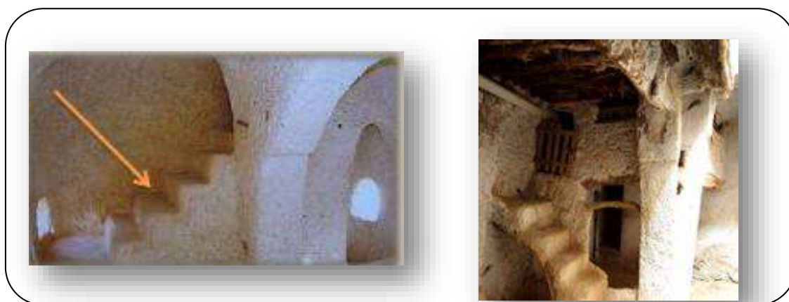
Photo (I.5) : Utilisation de troncs d'arbres pour supporter l'escalier
