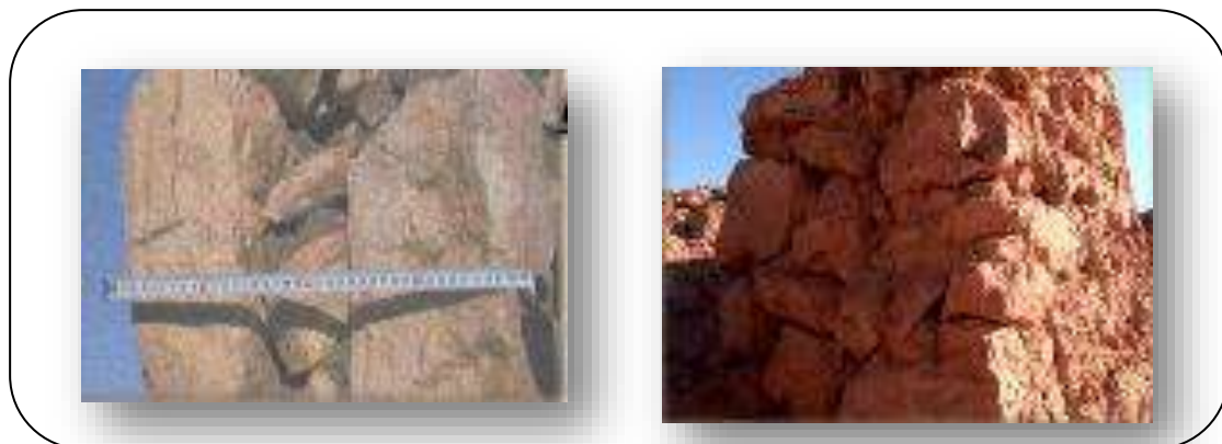
Photo (I.2) : Mur de pierre.
