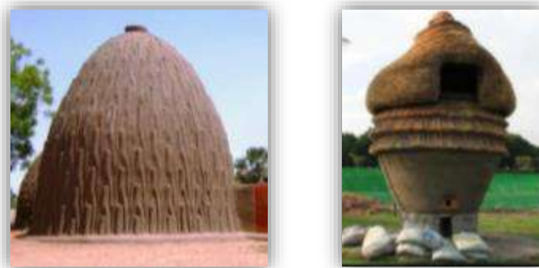
photo (I.16) : Construction En Terre Façonnée
