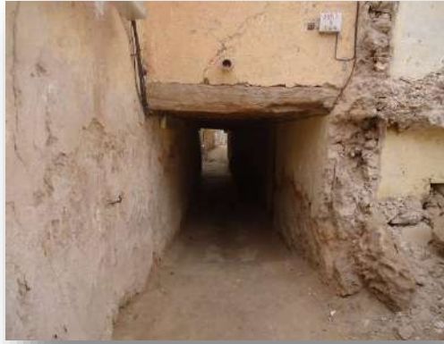
Photo (I.2) : poutre en tronc de palmier
