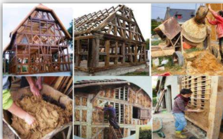
photo (I.8) : Technique De Construction En Torchis Alsace France
