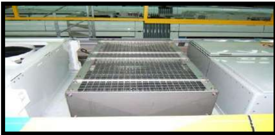
Rhéostat de freinage
