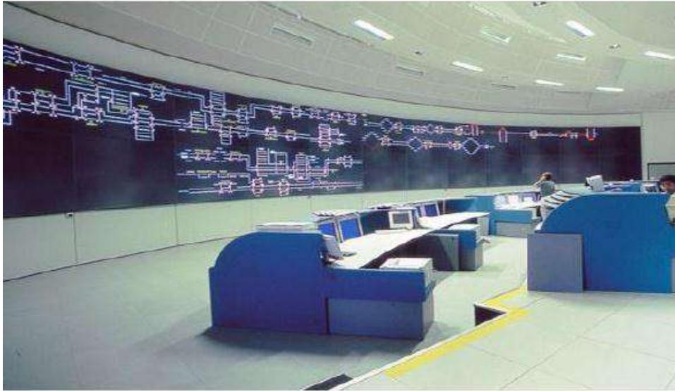
Figure II-4 : Système de contrôle et d'acquisition de données.
