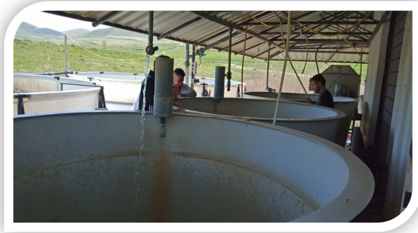
Photo n°07: les bassins circulaires de l'extérieur
