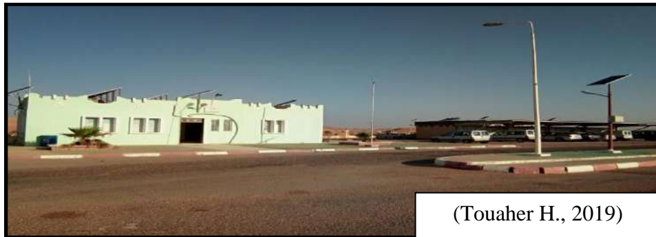
Photo 09: Bloc administratif et parking
