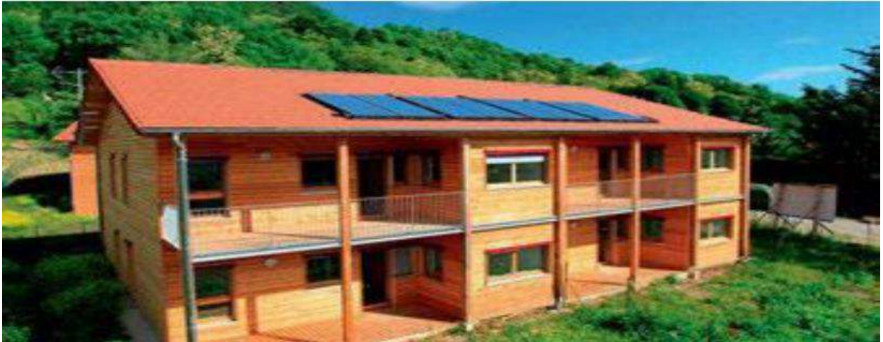
Figure 1.4 : Des logements sociaux BBC [5].
