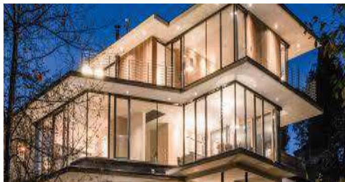
Figure I.4: les surfaces vitrées. [9]
