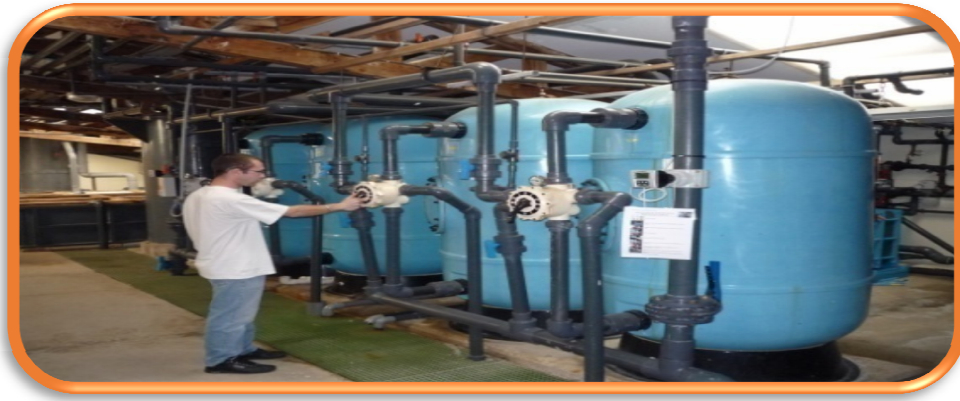
FigureN°04 :Cuves de filtration branches en parallèle(Ifremer Palavas - G. Lemarié 2009©Ifremer)
