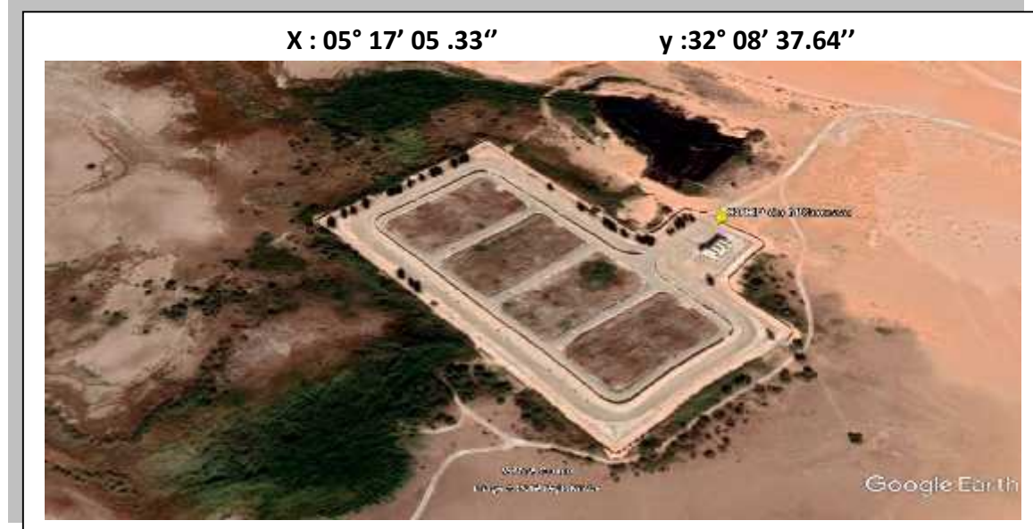
Figure 3- 3:Station d'épuration de N'Goussa(Google Earth)
