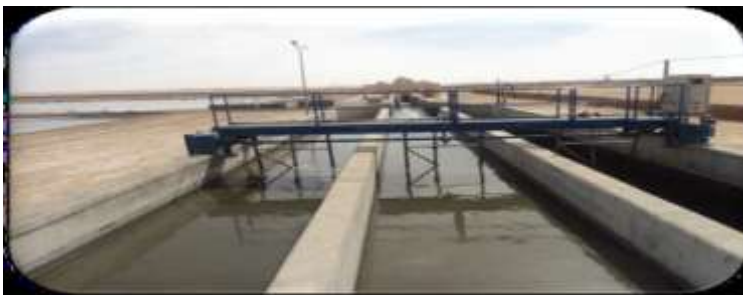
Figure (II-05) : Dessableur dans la station d'Ouargla.
