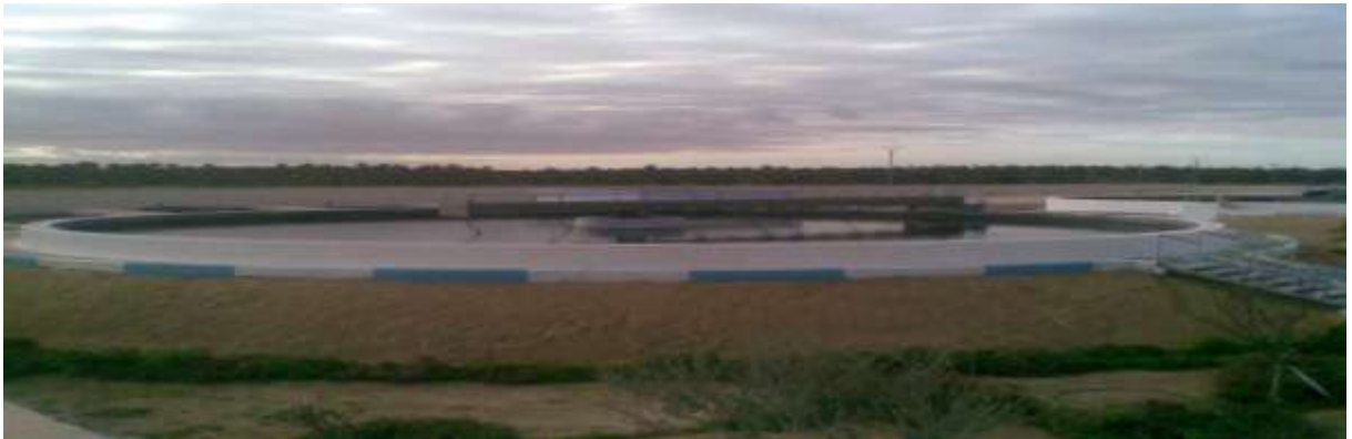
Figure (II-13) : Décanteur secondaire dans la station de Touggourt.
