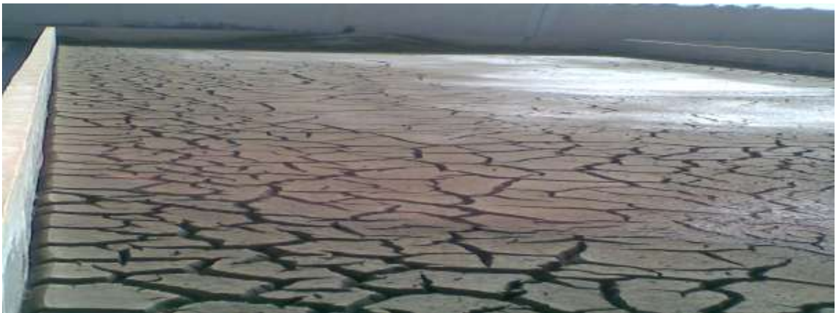
Figure (II-17) : Lits de séchage dans la station de Touggourt.
