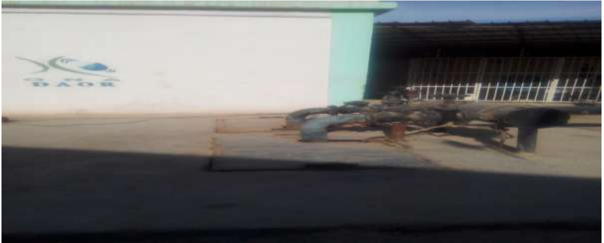
Figure (II- 09) : Relevage dans la station de Touggourt.
