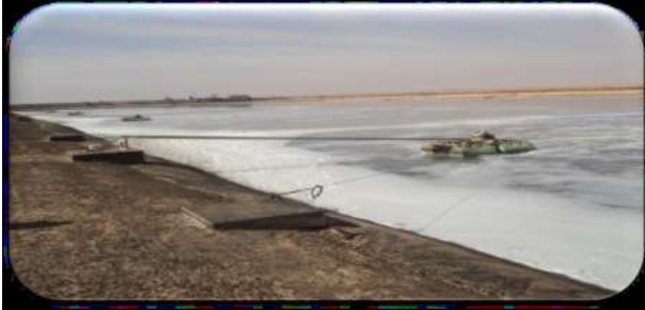
Figure (II-06): lagune d'aération dans la station d'Ouargla.
