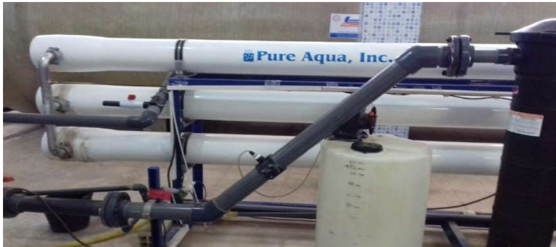
Figure .10. Membranes d'osmose inverse (Station Sarl Ben Amor).
