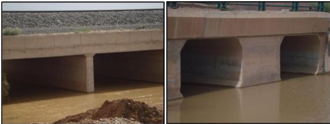
Figure 17. Les ouvrages de chemin de fer avec des ouvertures étroites.
