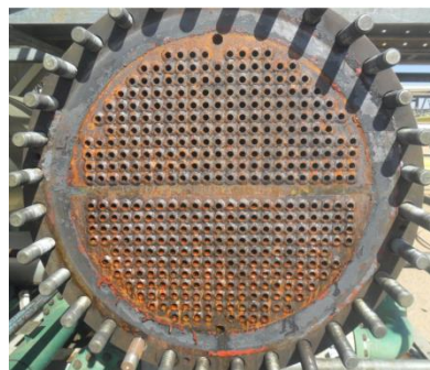
Figure I.16 : la plaque tubulaire de l'échangeur 12X20400A
