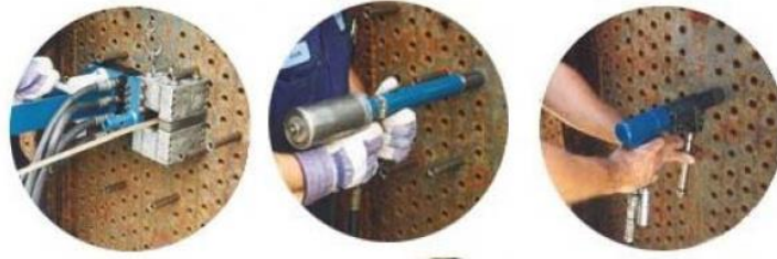
Figure II.3 : Nettoyage à l'aide d'un pistolet hydraulique
