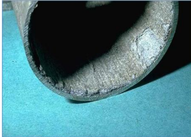
Figure I.5. La corrosion inter granulaire.
