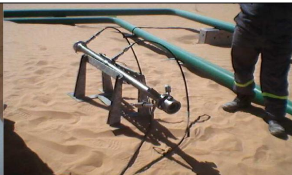
Figure 41: extracteur de coupon de corrosion
