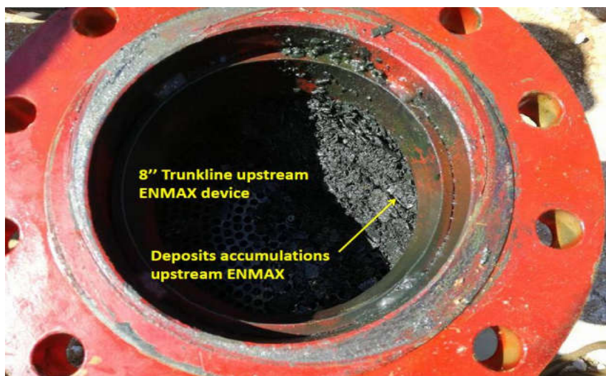
Figure V.3 : Accumulation de dépôts dans l'Enmax en amont.
