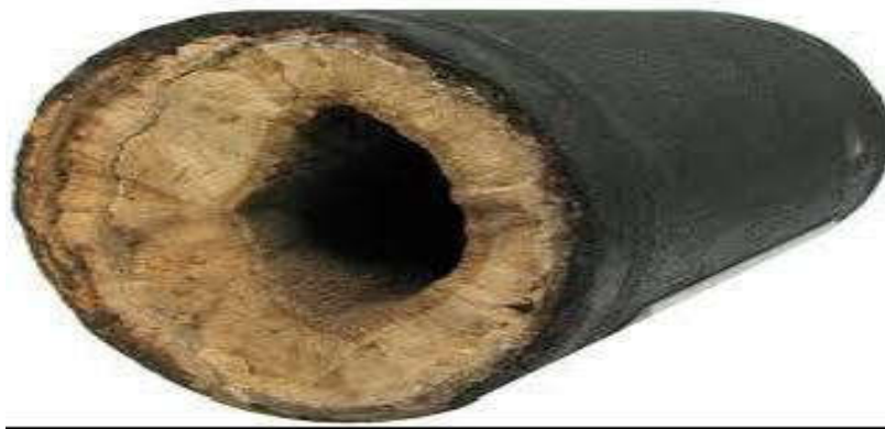
Figure II.7 : dépôt de sulfate de calcium
