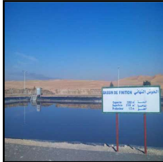
Photo N° 8: Bassin de finition
