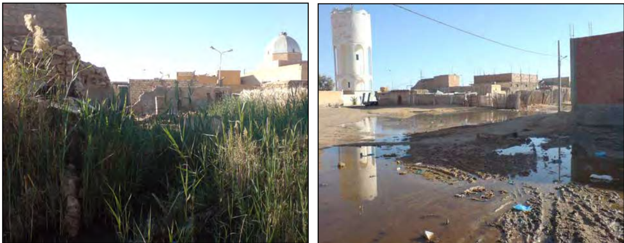
Figure 72. La situation de la nappe libre dans les zones urbaines (Sidi Mestour) (Photo Miloudi A.M, 2012)
