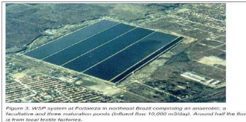
الشكل (13): محطة معالجة 10000 m 3 /ج نصفها صناعي (البرازيل) برك تثبيت لاهوائية ثم اختيارية وثلاثة برك إنضاج [29].
