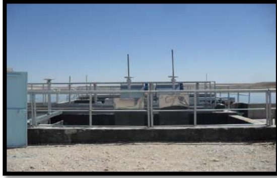
الشكل (28): نظام الغربلة و إزالة الرمل.
