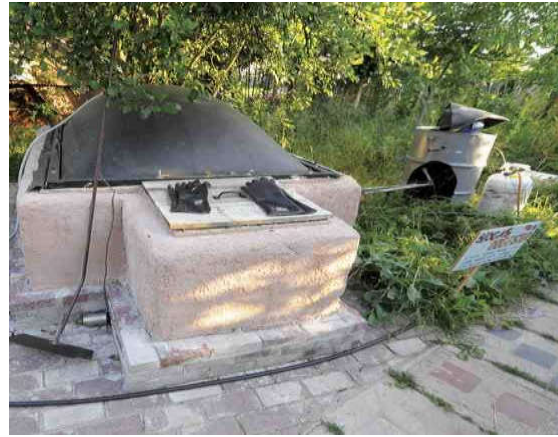
الصورة 3: وحدة إنتاج غاز الميثان (البيوغاز). الشكل 5: نموذج تخطيطي لوحدة انتاج الغاز. [22]
