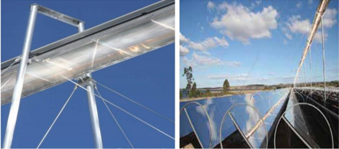
(الشكل II-5): صورة لعاكس فرينل خطي [20] [21].
