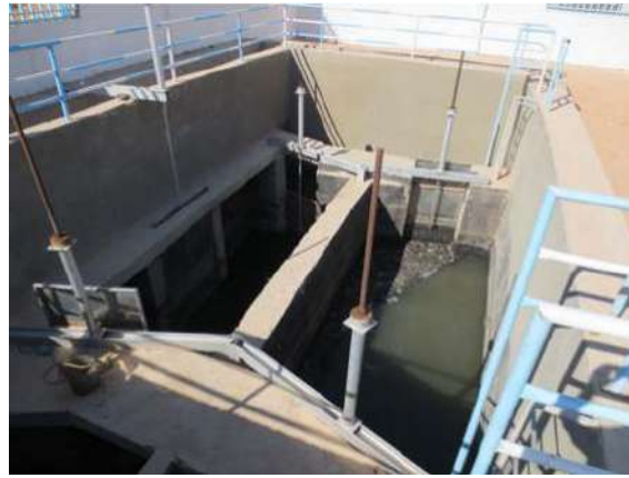
الشكل 15: أحواض الترسيد و ترسيب الرمال.
