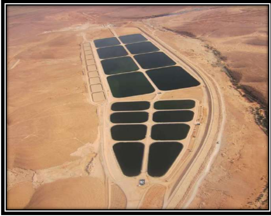
الشكل 12: منظر جوي لمحطة
