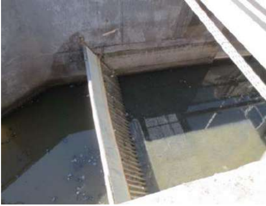
الشكل 14: شبكة ثابتة في القناة الالتفافية
