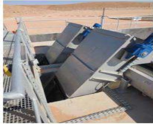
الشكل 13: جهاز الغريلة الميكانيكي
