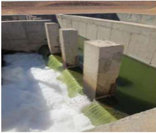
الشكل 16: خروج المياه من أحواض الترسيب
