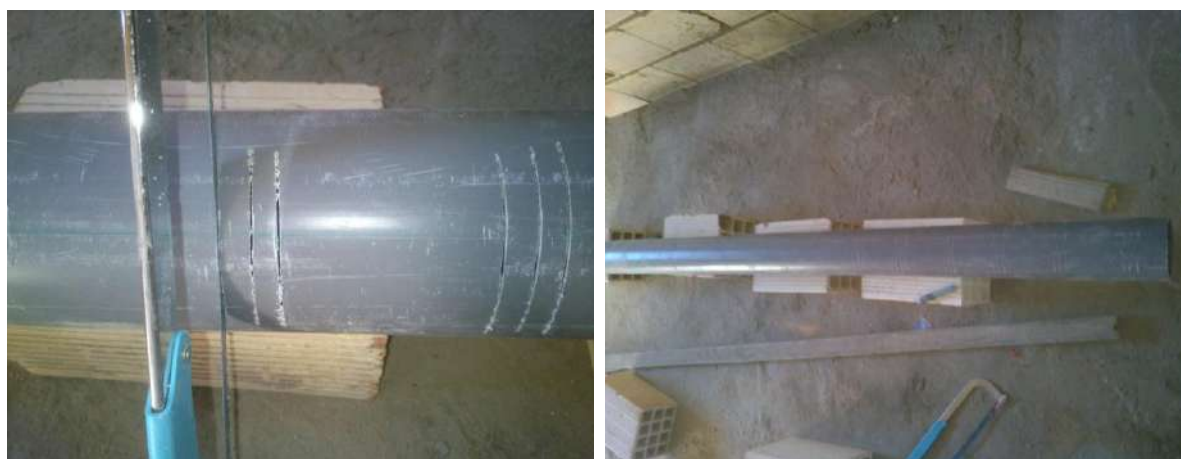
Fig.3. 4 Préparation des tubes des Piézomètre en PVC.
