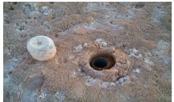
d) installation piézomètre intérieur sebkha.
