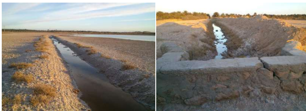
Fig.4. 37 Collecteur et réseaux de drainage des eaux d'irrigation
