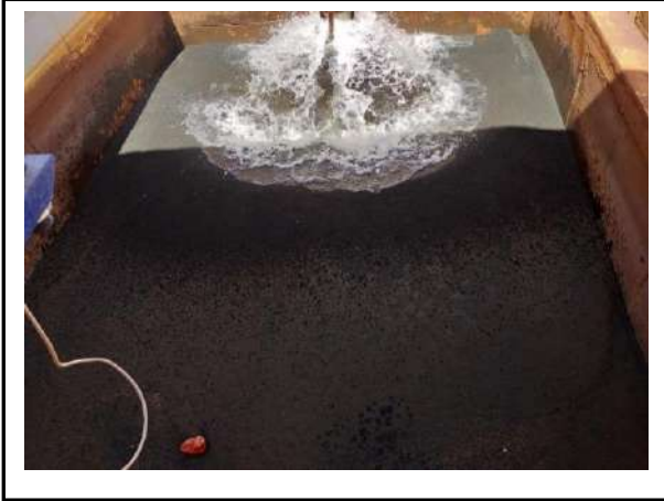
الشكل 43. أحواض الترسيب لمحطة نزع الحديد باليزي
