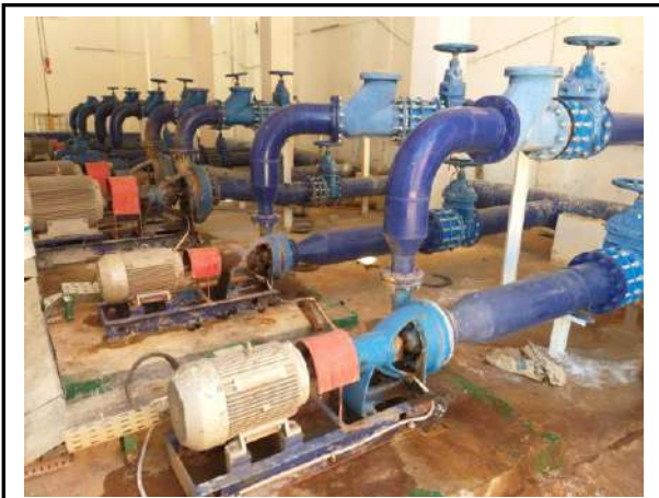
الشكل 45. خزانات التجميع وغرفة الضخ لمحطة نزع الحديد باليزي
