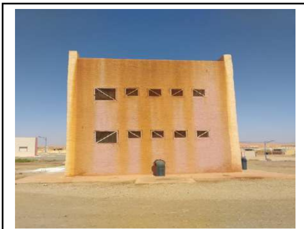
الشكل 42. شلالات التهوية لمحطة نزع الحديد بإبيزي
