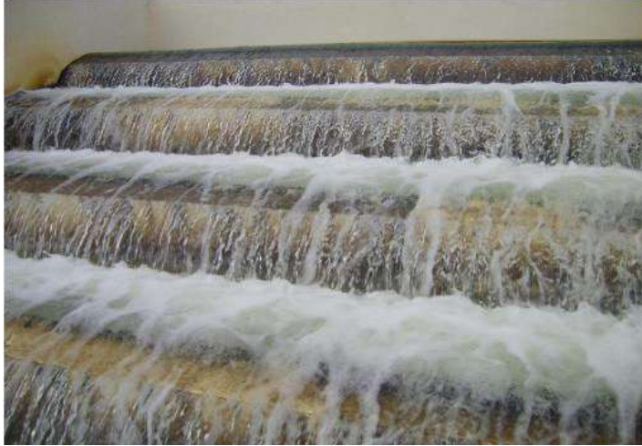
شكل 10. الأكسدة بالتهوية بالشلالات ( cascade )
