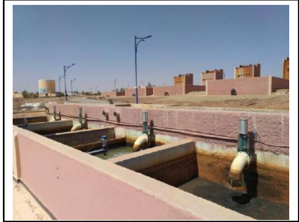
الشكل 43. أحواض الترسيب لمحطة نزع الحديد باليزي
