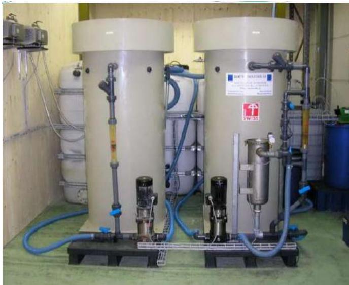
شكل 15. محطة إزالة الحديد بيولوجيا [19]
