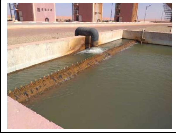
الشكل 43. أحواض الترسيب لمحطة نزع الحديد باليزي
