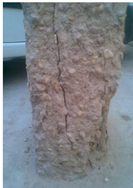
Photo II.6: Poteau réalisé à base de gravier roulé.
