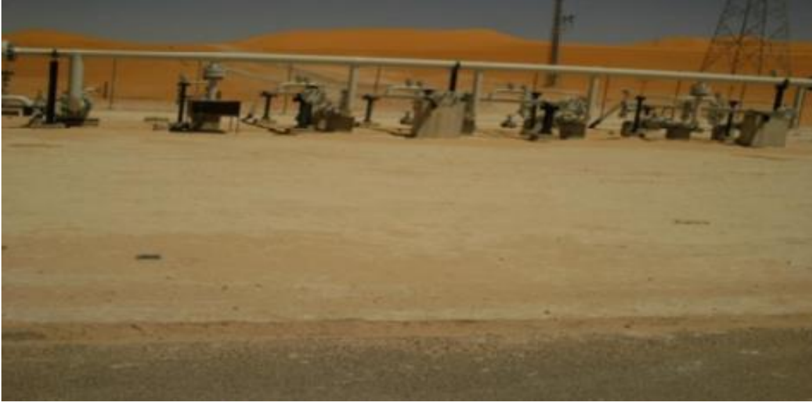
Figure I-11 : Manifold du gaz
