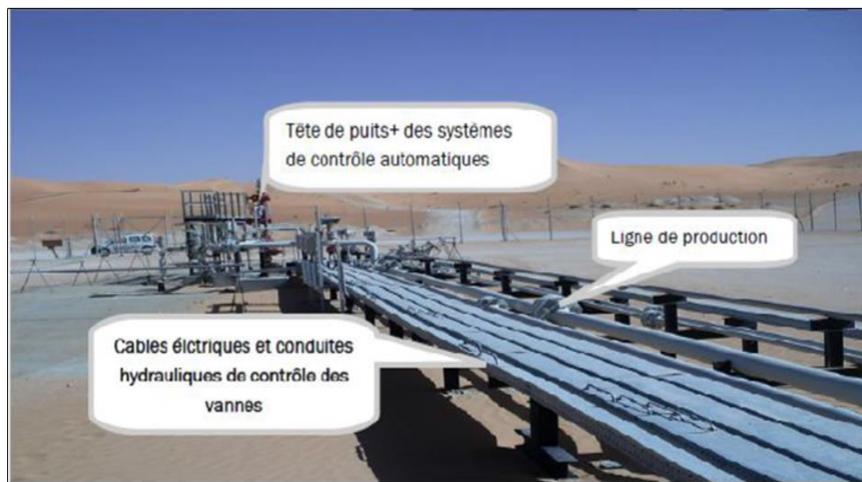
Figure I-5 : Vue d'un puits muni d'une nouvelle technologie d'installation de surface
