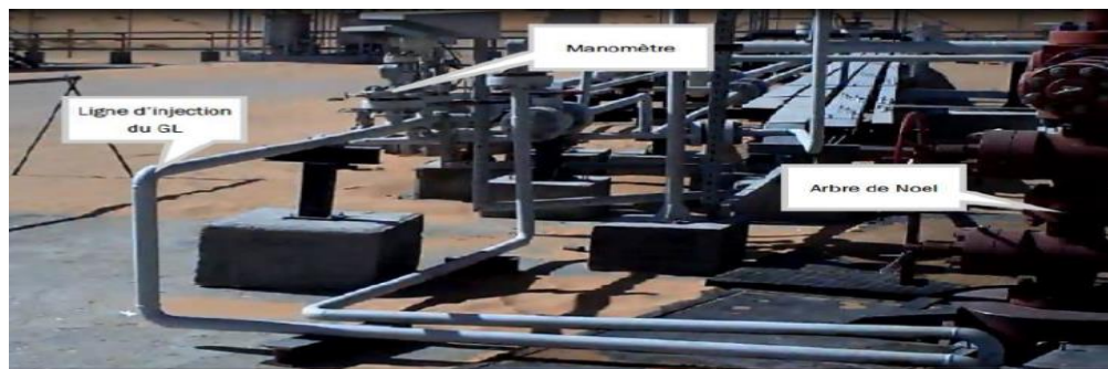
Figure I-8 : Système d'injection du GL
