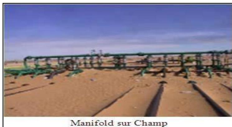
**Figure (II.7) : un manifold [11]**
