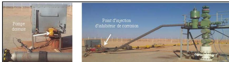
Figure (II.18) : la méthode d'injection d'inhibiteur [15]
