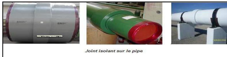
**Figure (II.5) : les joints isolant [11]**
