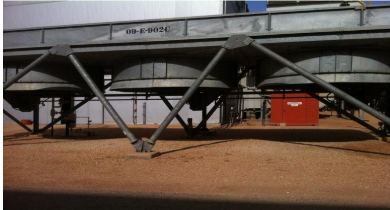
Figure II- 8. Les trois aéro-réfrigérants
