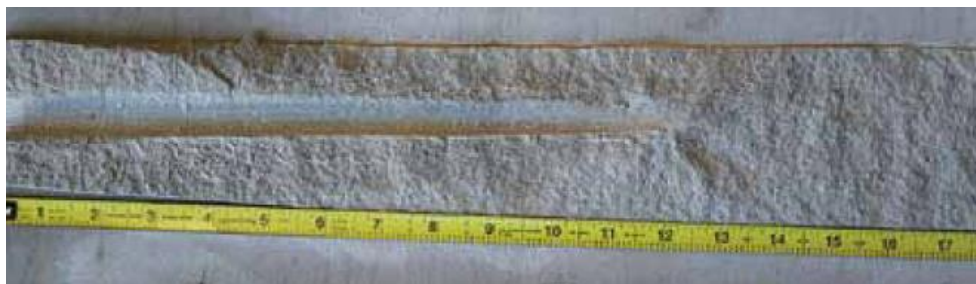
Figure III.6 : tunnel crier par la powerjet
