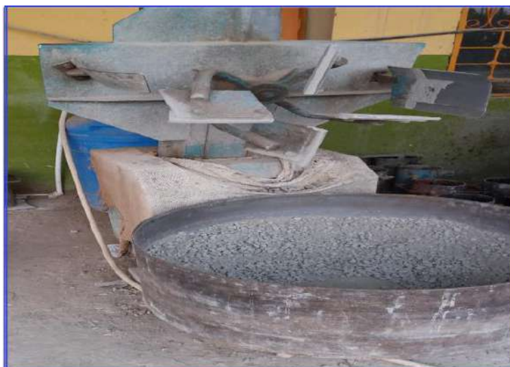
Photo V.14. Opération de malaxage du béton.
