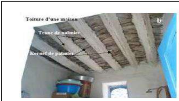
Figure I.6 : Utilisation du stipe de palmier et de kernef dans la toiture d'une maison.
