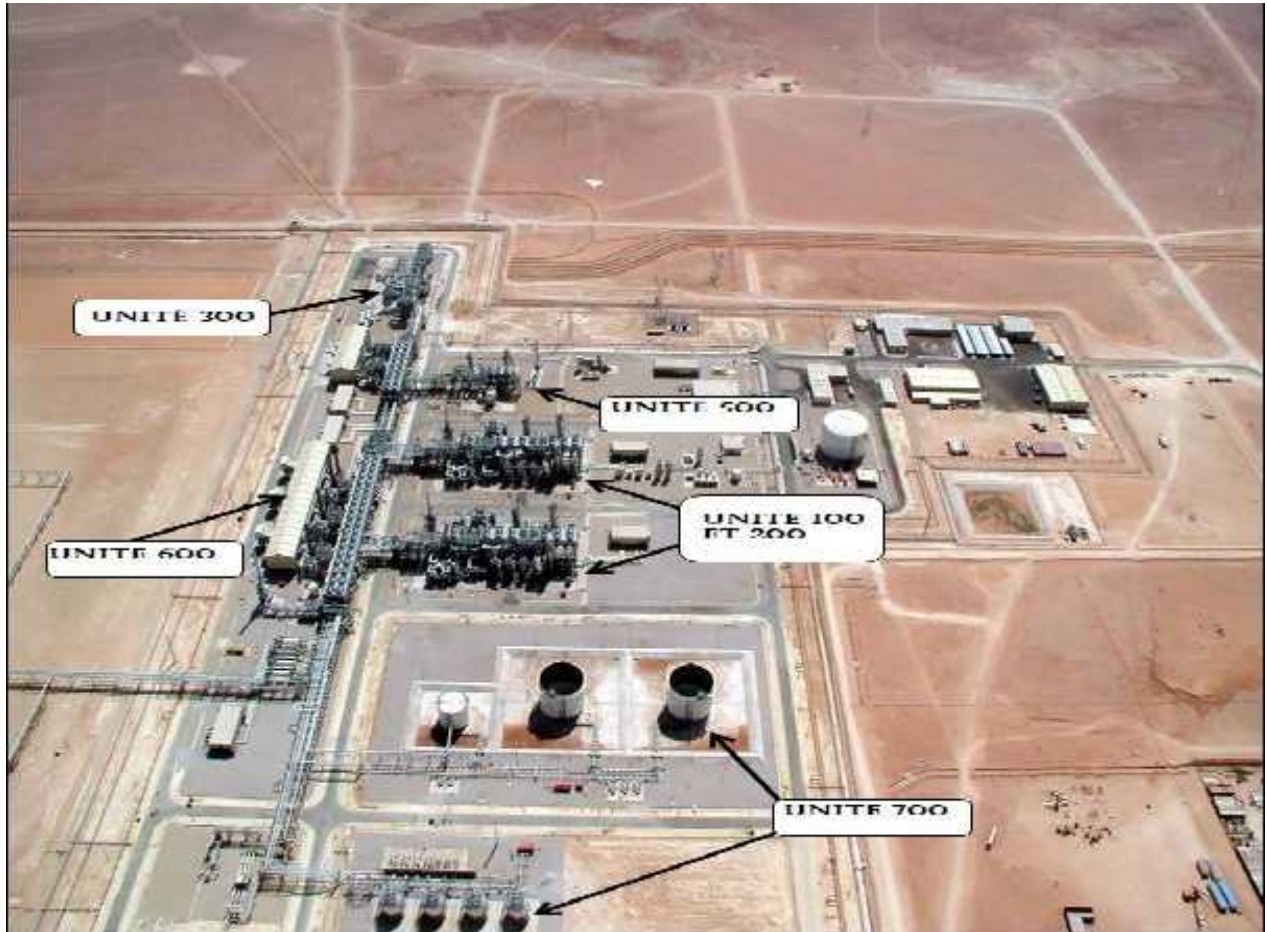
Figure III.3 : Vue générale des différentes unités du CPF
