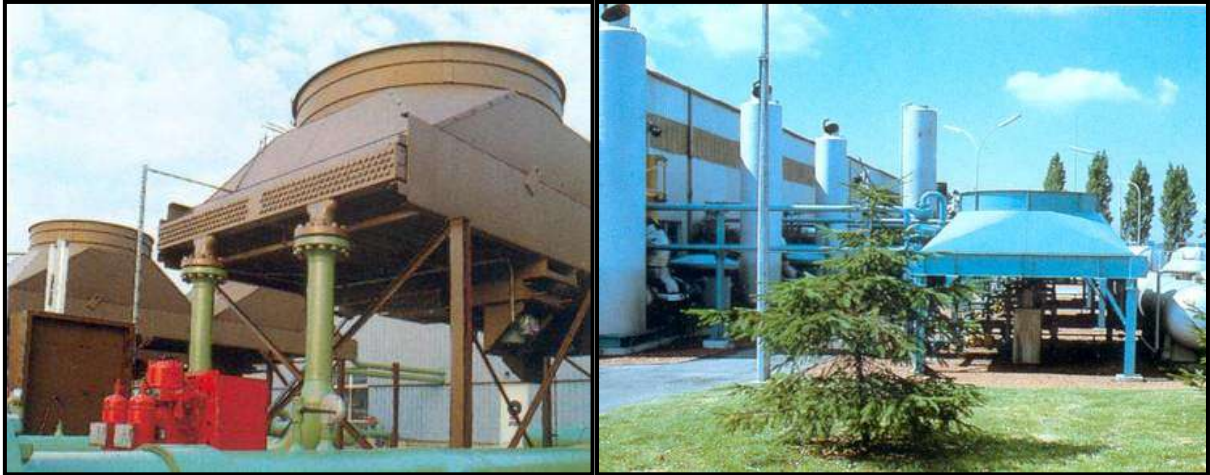
Figure III.31: Aéro-réfrigérant
