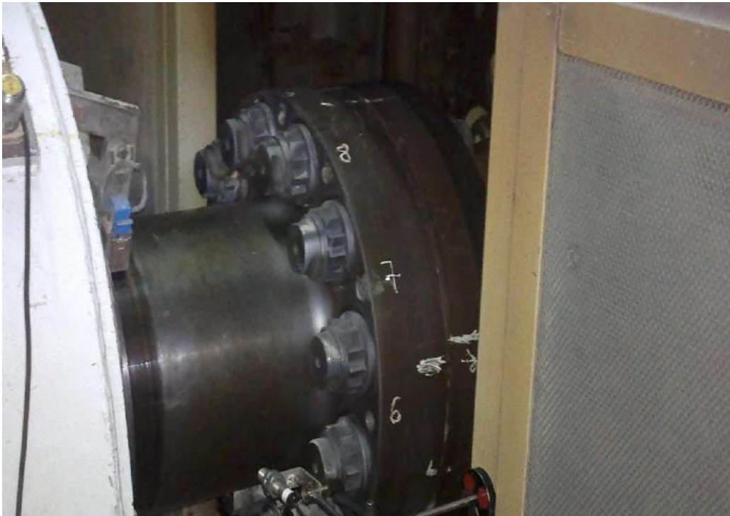
Figure 0.13: Plan d'équilibrage palier N°4 Alternateur
