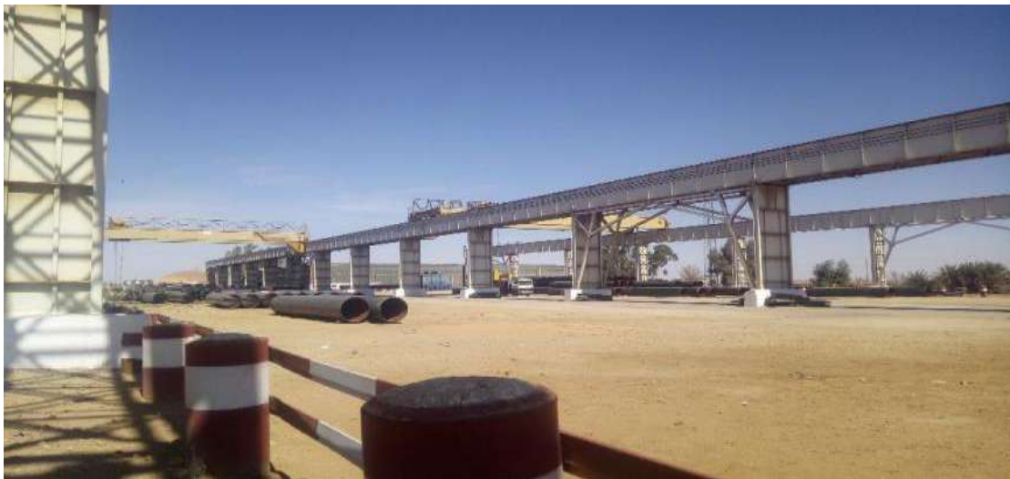
Figure I.49 Où sont stockés les tuyaux fabriqués
