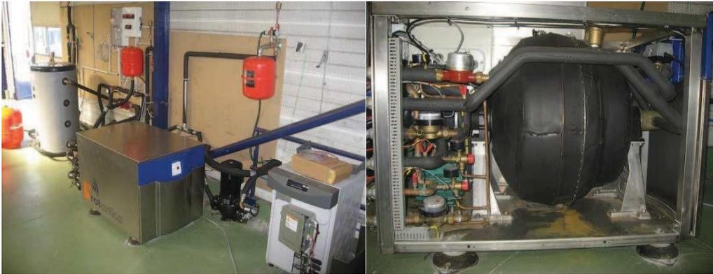
الشكل (III-6): صورة من غرفة نظام التبريد الشمسي بالامتصاص [69].
