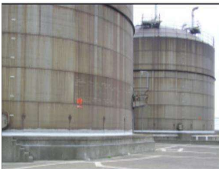
Figure II. 8 Application terminée pour deux réservoir [11]
