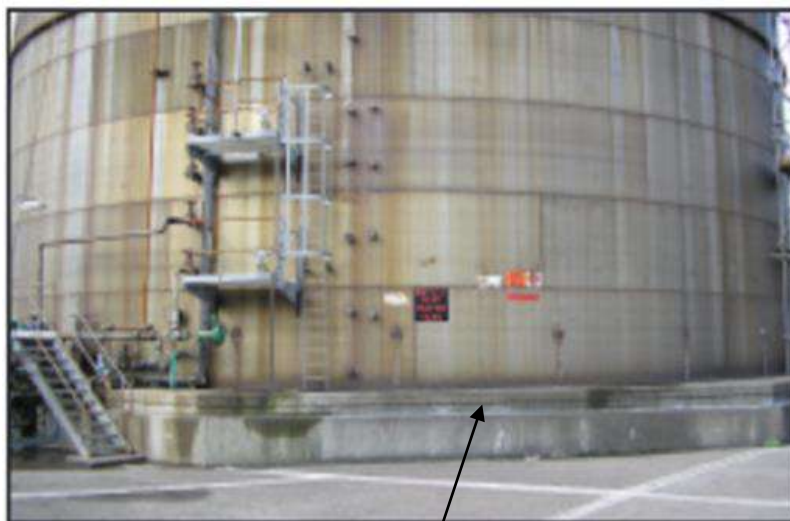
Figure II. 5: Béton de fondation porte la structure du réservoir[11]
