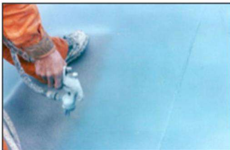
Figure II. 11: La protection extérieure du réservoir par l'opération de pulvérisation d'une résine à base du polymère[11]
