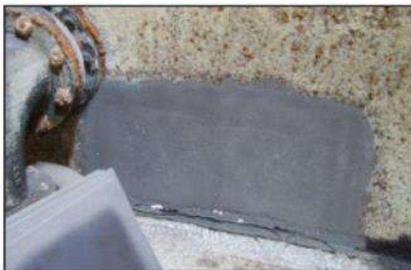
Figure II. 15: Composite à base d'époxy [11]
