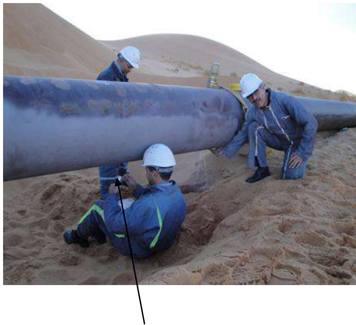
Figure II. 34: Rebouchage des percements par Patch composite[10]
