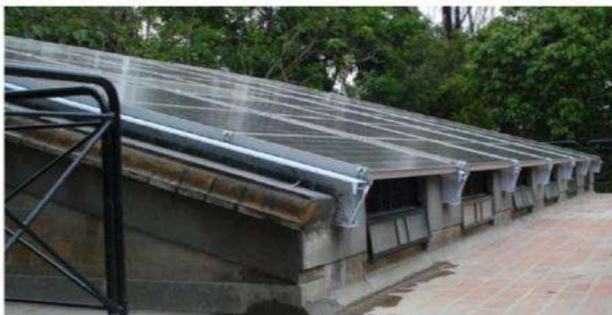
Figure 2.31: Système BIPVT monté sur le toit, New Delhi, Inde [77]
