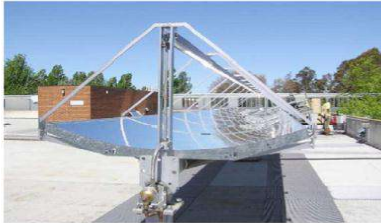
Figure 2.37: Système CPVT à creux parabolique [83].
