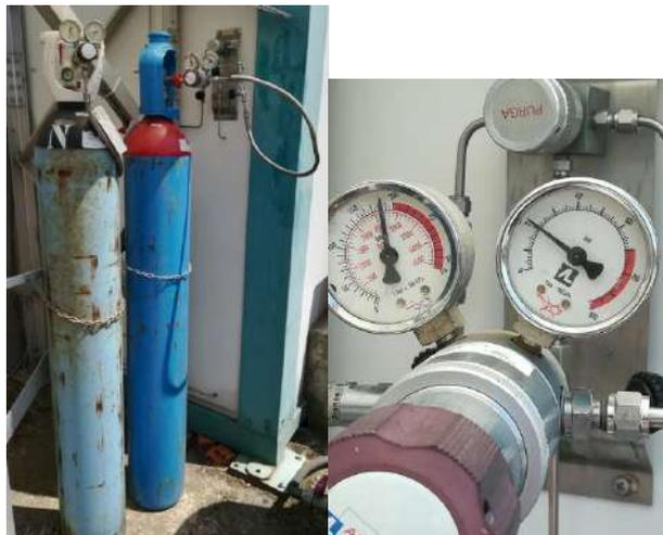
Bouteille d'hydrogène et son détendeur 200/20 bar
