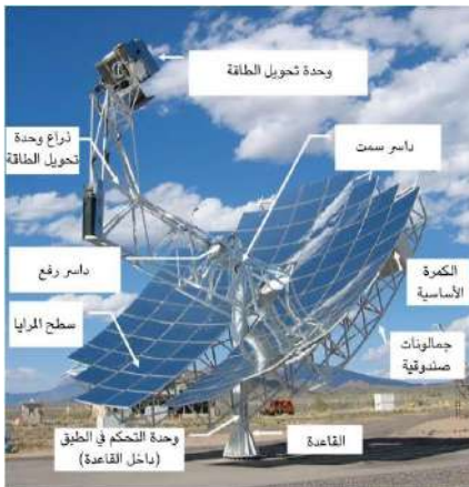
الشكل (I.14): بعض المركبات النقطية (أبراج شمسية وأطباق قطع مكافئ) [21]
