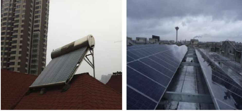
الشكل (8.II): صورة فوتوغرافية لـ DSWH ونوع السقف BIPV [31]
