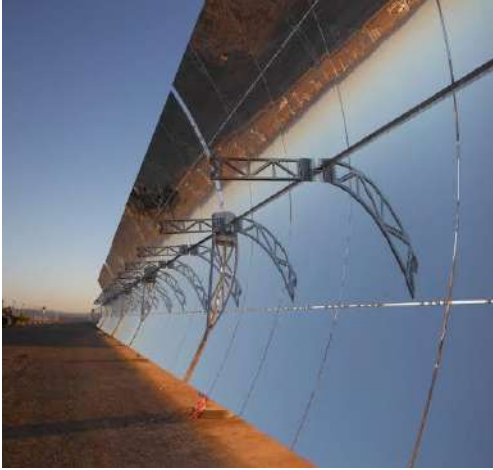
الشكل (17.I): بعض المركزات الخطية (عاكس فرنيل الخطي و الأسطوانى القطع المكافئ) [23]
