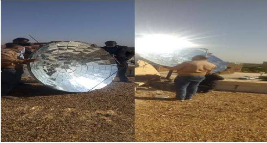
الشكل (4-13): تركيب الصحن الشمسي بالقطب الجامعي رقم 03.
