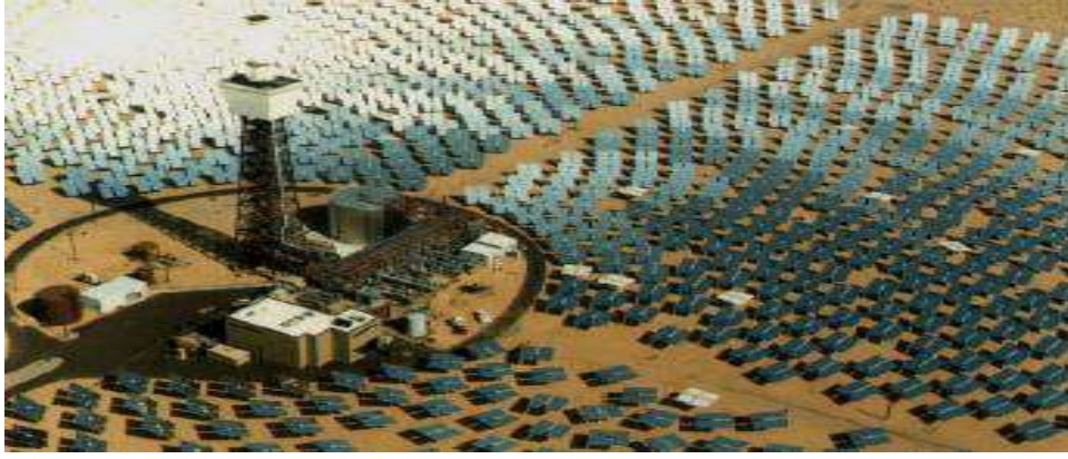
الشكل(2-12): صورة لمحطة شمسية تعتمد على تقنية برج القوي.[1]
