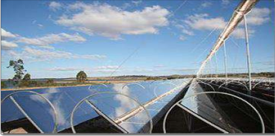
الشكل(2-14): تقنية فريزل المسطحة.[1]
