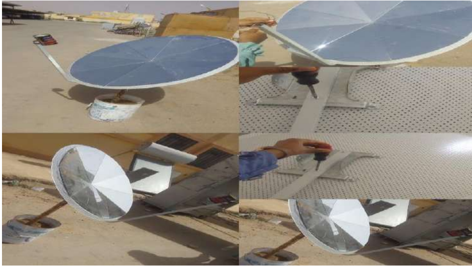
الشكل (4-14): عملية تركيب الصحن الشمسي فالقطب الجامعي رقم 01.
